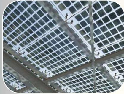
Des cellules photovoltaïques intégrées au vitrage fournissent l'énergie nécessaire au système de pompage et d'éclairage des cultures High-Tech. Côté logements, des panneaux solaires thermiques offrent une meilleure qualité de vie aux réfugiés climatiques en participant au chauffage des logements containers et à la production d'eau chaude sanitaire.
