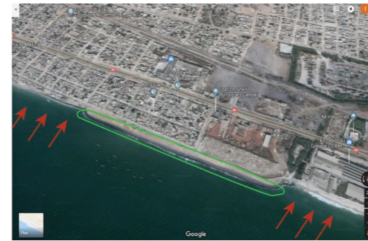
Digue de Rufisque
